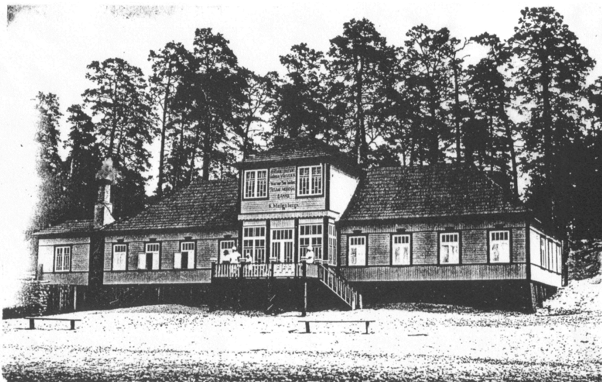
Attēls 24. Silto vannu iestāde Jūrmalā, Bulduros. Galvenā ēka no jūra puses. Fotofiksācija ap 1925. gadu.
